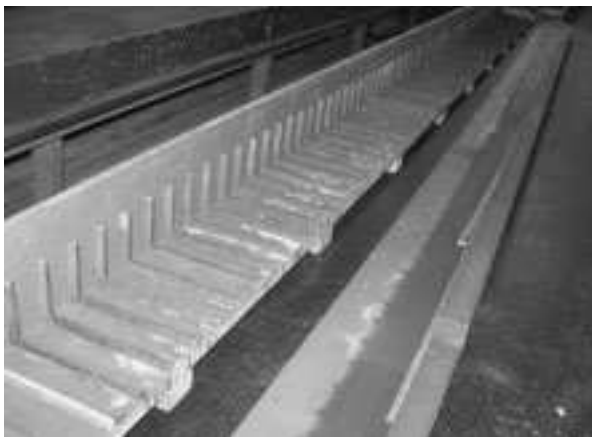
Bild 11 In der Holzschalung sind bereits Ausparungen für die Fugen des Sturzes mit einer Auskratztiefe von 15 mm berücksichtigt
