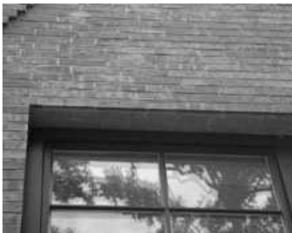
Bild 8 Verzinkte Stahlprofile stellen eine kostengünstige Überdeckung von Wandöffnungen dar, haben allerdings den Nachteil, daß sie von außen sichtbar bleiben
