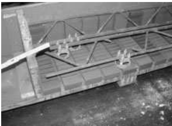
Bild 12 Die profilierten Winkelriemchen werden unter Einhaltung der Stoßfugen in die Schalung per Hand eingelegt. Die Bewehrung wird auf Stelzen gesetzt, um die 20 mm Mindestüberdeckung mit Beton einzuhalten
