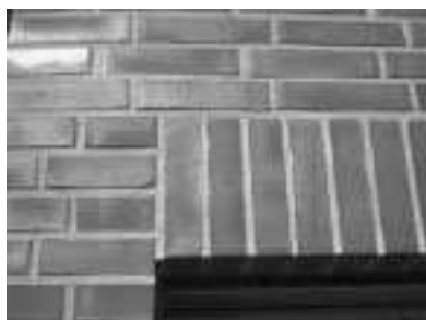
Bild 7 Kann keine tragende Funktionen übernehmen – das senkrecht angeordnete Widerlager
