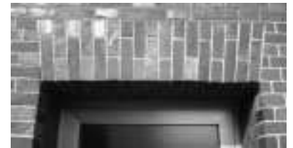
Bild 3 1 1/2 steindicker scheinrechter Bogen
