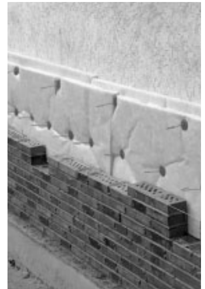
Bild 3 Ausführung der Verblendschale mit Wärmedämmung und Drahtankern nach DIN 1053-1
