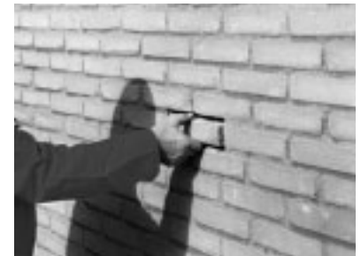
Bild 7 Einsetzen des Mauersteins nach der Verfüllung der Hohlschicht mit Dämmstoff
