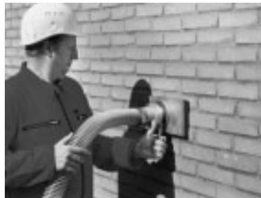
Bild 6 Einblasen des Dämmstoffes
