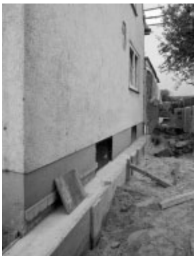
Bild 1 Neues Streifenfundament für die Verblendschale
