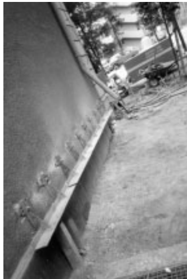
Bild 2 Winkelkonsolen an einer bestehenden Putzfassade zur Errichtung einer neuen Verblendschale
