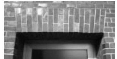
Bild 3 1 1/2 steindicker scheinrechter Bogen
