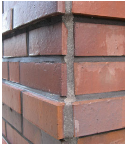
Bild 5. Vertikale Dehnfugen werden an Gebäudeecken zur Vermeidung von vertikalen Rissen angeordnet. Sie können unterschiedliche Gestaltungsformen annehmen (a). Eine Versiegelung der dauerelastischen Dichtstoffe ist sowohl aus optischen Gründen als auch zur Verlängerung der Lebensdauer empfehlenswert (b) Fig. 5. Vertical expansion joints are located at building corners to avoid cracking. They can have different forms of design (a). A sanding of the permanently elastic sealant is recommended for both aesthetic reasons and to prolong the life (b)
