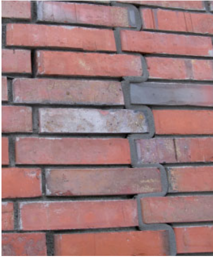
Bild 9. Kompribänder sind wegen der umständlichen Handhabung zur Versiegelung der Mäanderfugen nicht geeignet Fig. 9. Compressed bands are not suitable for sealing the meander dilatation joint because of complicated handling.
