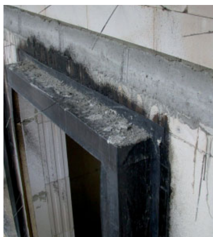
Bild 13. Bei Gebäuden in exponierter Lage kann durch die Abklebung der Dämmstreifen rund um die Fensteröffnung die Gefahr von Durchfeuchtungen als Folge von Schlagregen weitgehend ausgeschlossen werden
