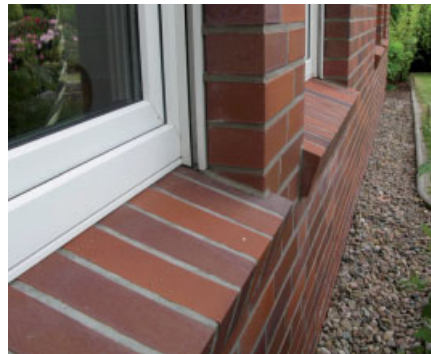
Bild 16. Fensterbänke aus gemauerter Rollschicht stellen die Standardbauweise bei fast allen Ein- und Zweifamilienhäusern mit Ziegelverblendmauerwerk dar. Je nach Lage des Gebäudes kann die Gefällebildung der Sohlbank eine schnelle Oberflächenverschmutzung verhindern (a). Bindet die Sohlbank in die Verblendschale ein, so wird verhindert, dass Regenwasser über die Rollladenschienenführung in die Hohlschicht gelangen kann (b).
