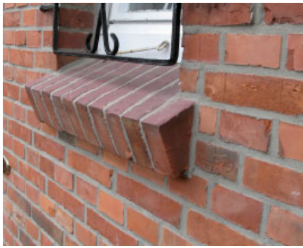
Bild 15. Fachgerecht und sorgfältig ausgeführte Sohlbänke aus gemauerter Rollschicht zeigen auch nach einer Standzeit von mehreren Jahrzehnten ein ansehnliches Erscheinungsbild
