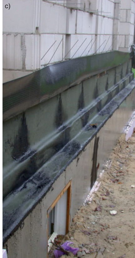
Bild 12. Der Einbau von zusätzlichen Sperrbahnen mit Gefällebildung in der Dämmebene ist sinnlos und führt zu einem enormen Mehraufwand bei der Sockelabdichtung (a) und (b). Hier reicht eine einfache Abdichtung, die vor der Errichtung der Verblendschale auf die tragende Innenschale aufgebracht wird. Die hochgeklappte Bahn auf Bild (c) ist nicht erforderlich
