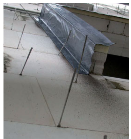
Bild 13. Bei Gebäuden in exponierter Lage kann durch die Abklebung der Dämmstreifen rund um die Fensteröffnung die Gefahr von Durchfeuchtungen als Folge von Schlagregen weitgehend ausgeschlossen werden
