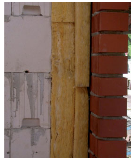
Bild 3. Durch die vollständige Verfüllung der gesamten Hohlschicht mit Wärmedämmung (200 mm) können die Anforderungen des Wärmeschutzes problemlos erfüllt werden
