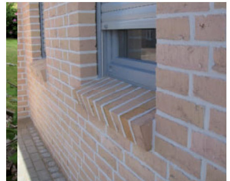
Bild 16. Fensterbänke aus gemauerter Rollschicht stellen die Standardbauweise bei fast allen Ein- und Zweifamilienhäusern mit Ziegelverblendmauerwerk dar. Je nach Lage des Gebäudes kann die Gefällebildung der Sohlbank eine schnelle Oberflächenverschmutzung verhindern (a). Bindet die Sohlbank in die Verblendschale ein, so wird verhindert, dass Regenwasser über die Rollladenschienenführung in die Hohlschicht gelangen kann (b).
