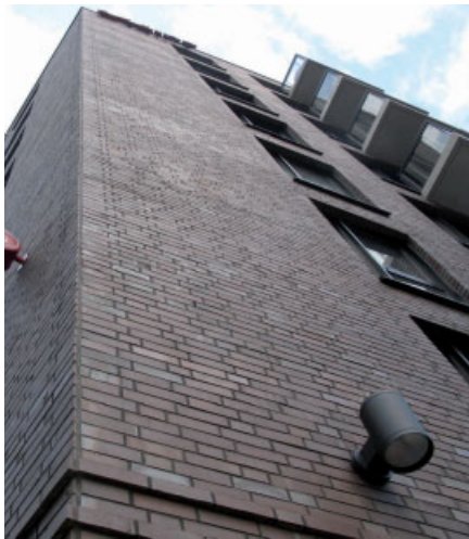
Bild 5. Vertikale Dehnfugen werden an Gebäudeecken zur Vermeidung von vertikalen Rissen angeordnet. Sie können unterschiedliche Gestaltungsformen annehmen (a). Eine Versiegelung der dauerelastischen Dichtstoffe ist sowohl aus optischen Gründen als auch zur Verlängerung der Lebensdauer empfehlenswert (b) Fig. 5. Vertical expansion joints are located at building corners to avoid cracking. They can have different forms of design (a). A sanding of the permanently elastic sealant is recommended for both aesthetic reasons and to prolong the life (b)
