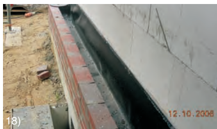
Bilder 17 und 18. Durch eine fachgerechte Abdichtung des Sockels vor Beginn der Mauerarbeiten der Verblendschale ist dafür gesorgt, dass die Innenschale dauerhaft vor Einwirkung des Regenwassers geschützt ist. Die Sperrbahnen werden an der tragenden Wand so befestigt, dass sie in ihrer Lage dauerhaft funktionsfähig bleiben (durch punktuelle Befestigung oder Verklebung)
