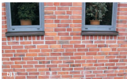
Bild 8. Stand der Baupraxis in Norddeutschland: Verblendmauerwerk wird ins Erdreich geführt, ohne eine Entwässerung unterhalb der Geländeoberfläche vorzusehen
