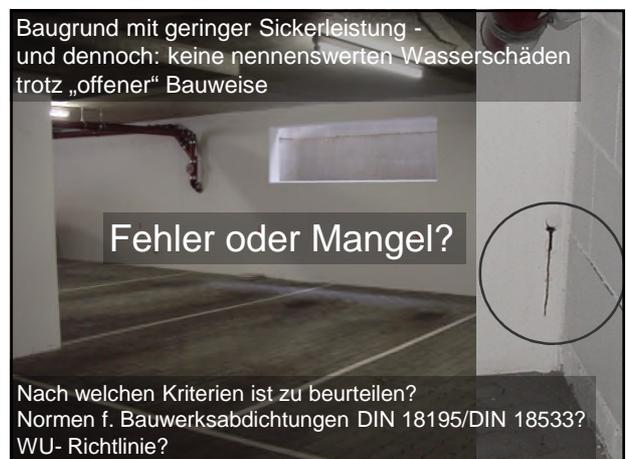
**WU-Richtlinie** und **DIN 18533** differenzieren hinsichtlich der erforderlichen **Maßnahmen zum Feuchteschutz** nach der Einwirkung, nicht (bzw. nur bedingt) nach der Ursache und somit **nicht nach drückendem Wasser und stauendem Sickerwasser** (Einwirkungsklasse **W2.1-E und W2.2-E**).
