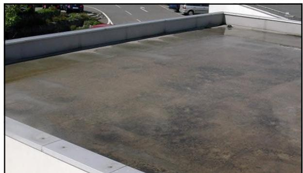
Nicht geplante Anstaubbewässerung eines Stahltrapezblechdachs ohne Gefälle
