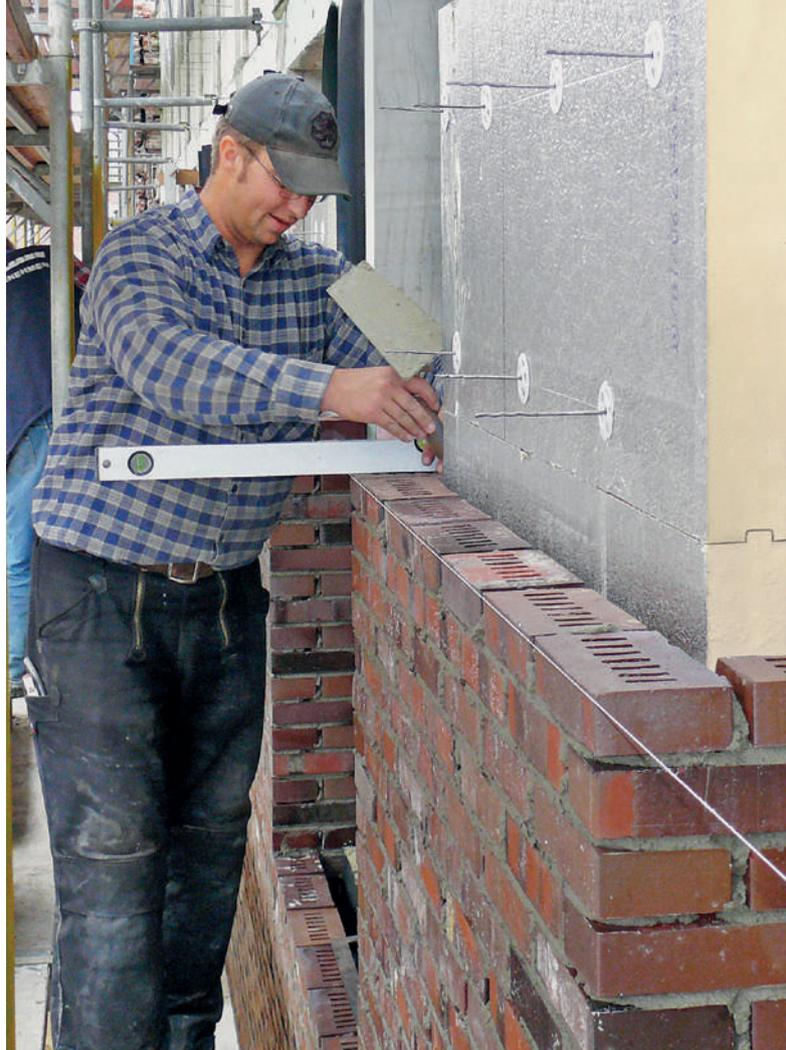
Bestehende zweischalige Konstruktionen, bei denen der Schalenzwischenraum nur teilweise mit einer Wärmedämmschicht ausgefüllt wurde, können mit Erneuerung der Verblendschale und einer hoch-effizienten PU-Kerndämmung ertüchtigt werden.
