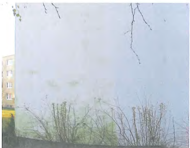
Bild 8 Beispiele einiger Farbbeschichtungen mit verschiedenen Biozidgehalten (Info des Herstellers), algenbesiedelt nach 3-jähriger Bewitterung
