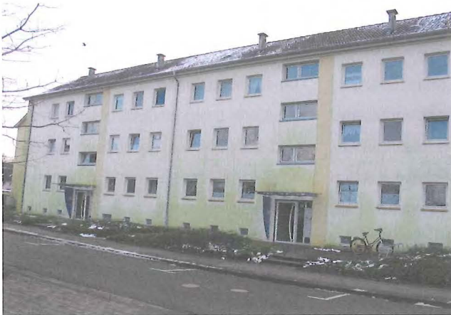
Beispiel einer stark algenbesiedelten Fassade: links - Fotoaufnahme im Dezember 2008 (Sanierung im 2003), rechts - PAM-Aufnahme
