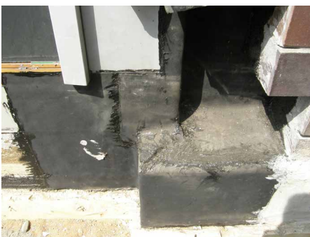
Abb. 15: Details der nachträglichen Schließung der Abdichtungslücke
