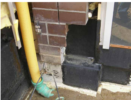
Abb. 14: Details der nachträglichen Schließung der Abdichtungslücke
