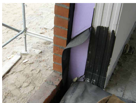
Abb. 32: Errichtung des Verblendmauerwerks
