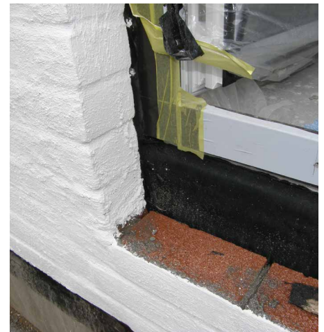
Abb. 33+34: Dritter und letzter Arbeitsschritt: Herstellung der Abdichtungsanschlüsse an den Tür- bzw. Fensterrahmen durch den Bauwerksabdichter
