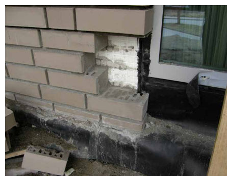
Abb. 23+24: Beispiel des Einbaus einer Sockelabdichtung aus 1,2 mm dicken EPDM-Bahnen in Verbindung mit Aussparungen im Bereich der Fensterleibungen
