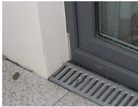
Abb. 8: Auf die seitliche Rahmenfläche geführte Flüssigkunststoff-Abdichtung bei einem Terrassentürelement
