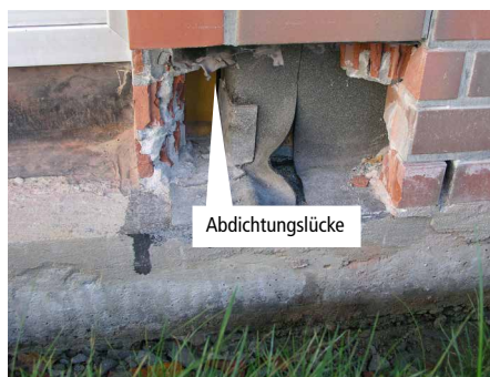
Abb. 17: Abdichtungsdetails
