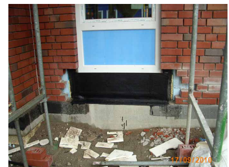
Abb. 25+26: Beispiel des Einbaus einer Sockelabdichtung in Verbindung mit Aussparungen im Bereich der Türleibungen (© R. Zellmer); Hinweis: Das bauausführende Unternehmen hat bei diesem Beispiel ganz bewusst und in Abweichung zu DIN 18195 Bitumen-Schweißbahnen verwendet.
