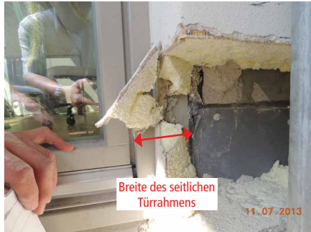
Abb. 9: Vor dem seitlichen Türrahmen endende Abdichtung aus beschichteten Blechen bei einem Balkon
