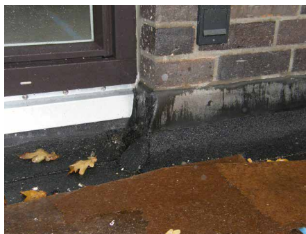
Abb. 42: Ausführungsbeispiel eines zum Teil verdeckt liegenden seitlichen Anschlusses einer Terrassenabdichtung in Verbindung mit zweischaligem Verblendmauerwerk vor Einbau des aus Holzbohlen bestehenden Belags
