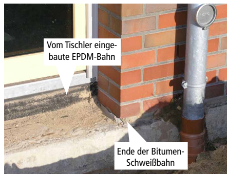
Abb. 16: Abdichtungsdetails
