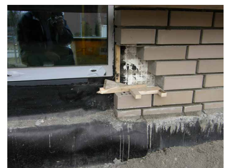
Abb. 23+24: Beispiel des Einbaus einer Sockelabdichtung aus 1,2 mm dicken EPDM-Bahnen in Verbindung mit Aussparungen im Bereich der Fensterleibungen
