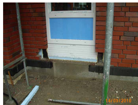
Abb. 25+26: Beispiel des Einbaus einer Sockelabdichtung in Verbindung mit Aussparungen im Bereich der Türleibungen (© R. Zellmer); Hinweis: Das bauausführende Unternehmen hat bei diesem Beispiel ganz bewusst und in Abweichung zu DIN 18195 Bitumen-Schweißbahnen verwendet.
