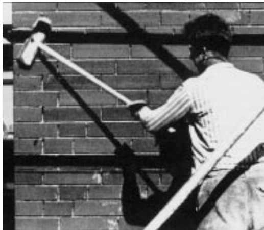
Abb. 4: 2. Angriffsfläche: Beim Absäuern wird der Mauermörtel in den offenen Fugen durch die Säure angegriffen.
